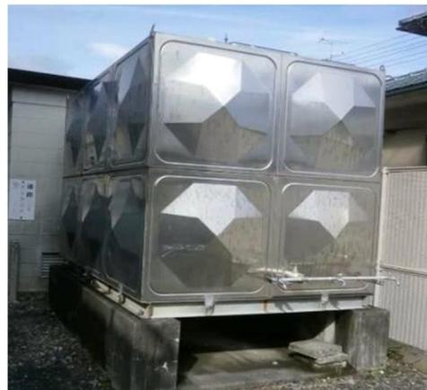
写真- 1 8 給水栓付受水槽（静岡市）
