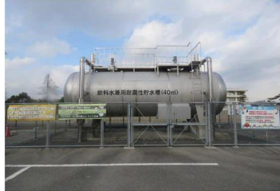
写真- 2 耐震性貯水槽（輪之内町）
