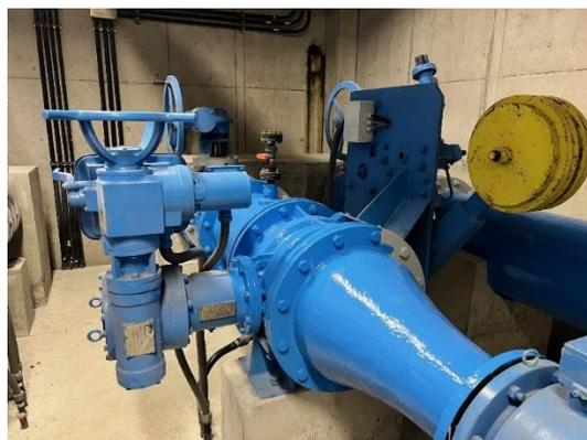
写真-14 緊急遮断弁（御嵩町）
