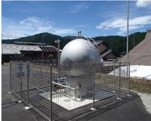
写真- 1 耐震性貯水槽（豊田市）
