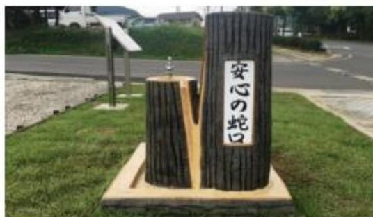
写真-7 応急給水拠点（長野県）
