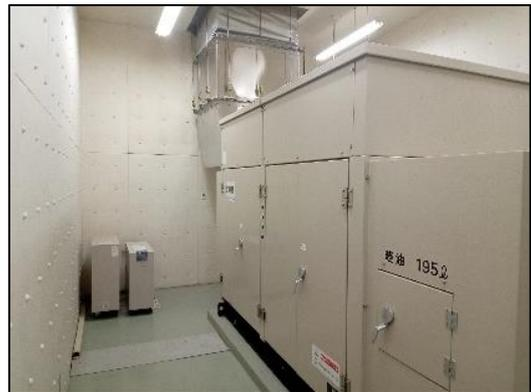
写真-13 非常用発電設備（養老町）
