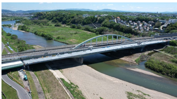
国道 302 号 庄内川橋
