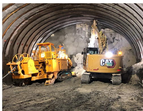
道路 3 高山清見道路(中部縦貫自動車道)(岐阜県)
