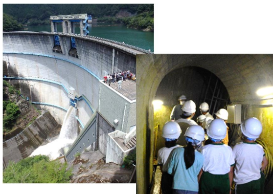
河川 18 新豊根ダム(愛知県)
