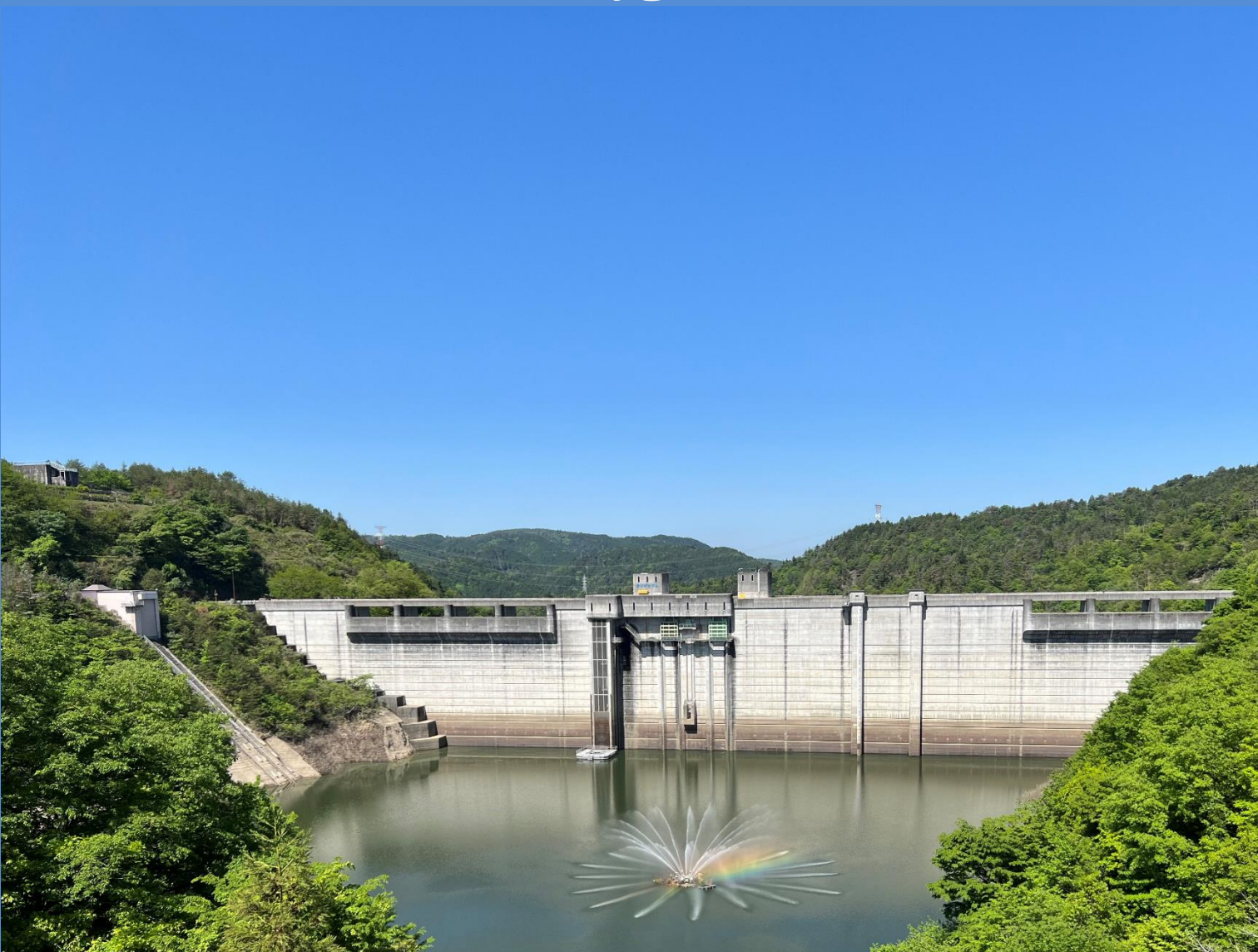
庄内川小里川ダム（岐阜県）
