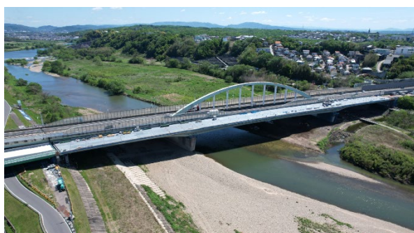
国道 302 号 庄内川橋
