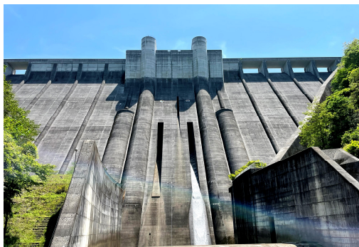
▲常用洪水吐からの放流
