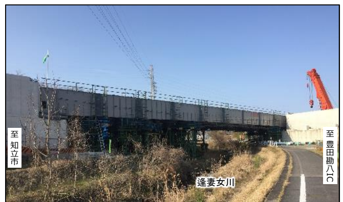
【写真④】横山橋上部工架設状況
