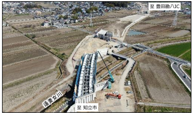
【写真②】豊田IC側から豊田勘八IC方面を望む
