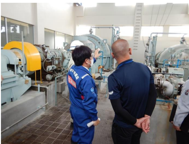
排水機場の点検
