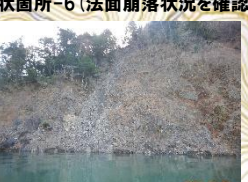
変状箇所-6(法面崩落状況を確認)
