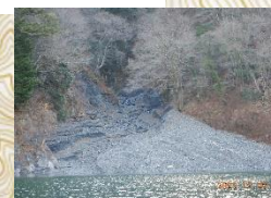
重点点検箇所 桂沢 (土砂・流木の流出状況を確認)
