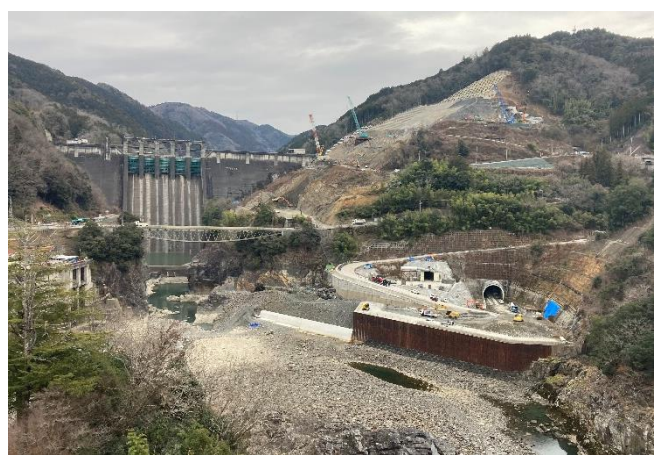
新丸山ダム本体付近施工状況
