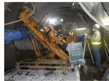
集水ボーリング工
