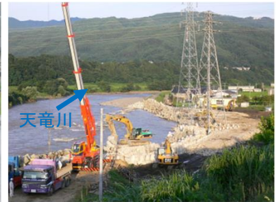
平成18年7月豪雨応急復旧状況
