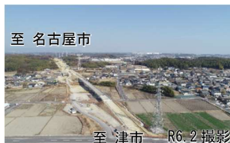
北勢バイパス 国道477号バイパス交差点付近
