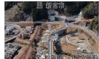
熊野道路 熊野大泊IC付近
