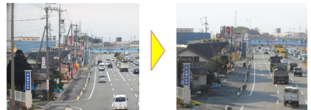
【整備事例】国道23号 伊勢北電線共同溝
