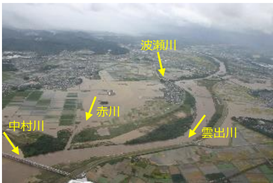
H21.10洪水 浸水状況
