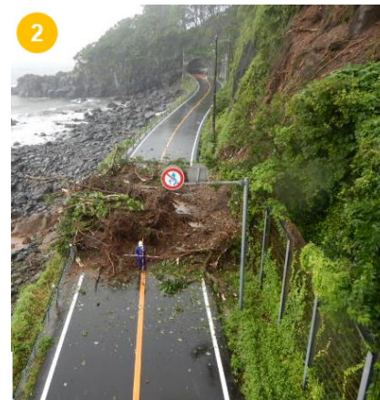
【国道 135 号 法面崩壊】 (令和 2 年 7 月 伊東市赤沢)
