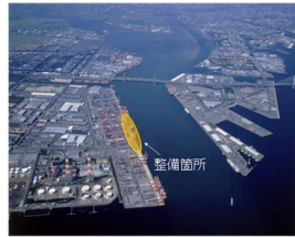
名古屋港飛島再編整備事業 (飛島ふ頭地区)
