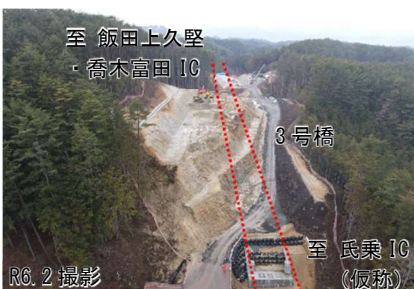
さんえんなんしん 三遠南信自動車道 いいだか 飯喬道路 3号橋付近
