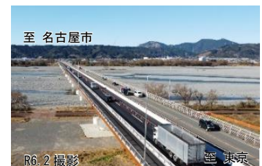
しまだかなや 島田金谷バイパス しんおおいがわ 新大井川橋付近
