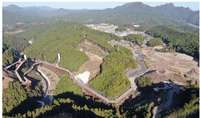
工事用道路(廃棄岩骨材運搬路等)
