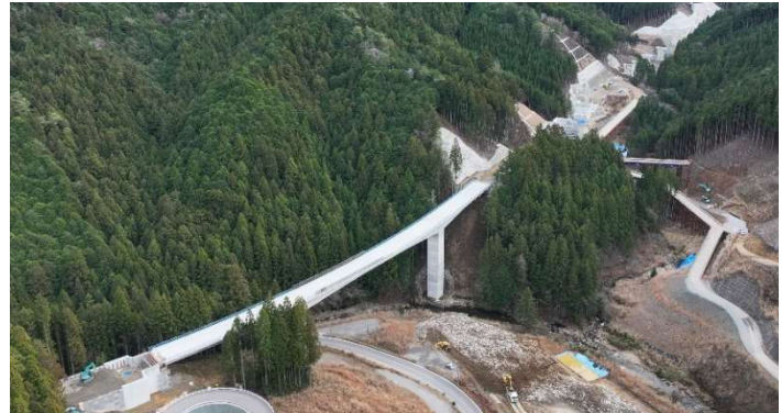
付替県道設楽根羽線(5号橋)
