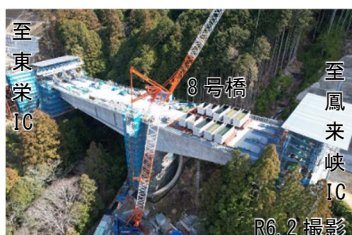
三遠南信自動車道 佐久間道路・三遠道路 8号橋付近
