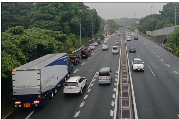
《《オフランプの車線拡幅を予定》》
