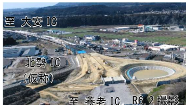
東海環状自動車道 北勢IC(仮称)付近
