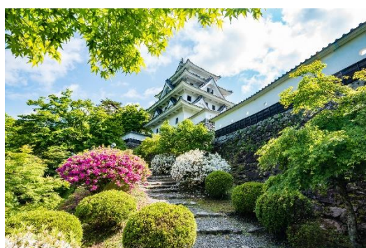
耐震補強工事を終えた郡上八幡城
