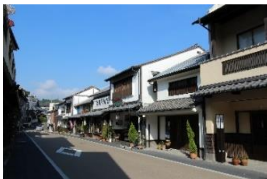
電線類無電柱化を実施した通り
