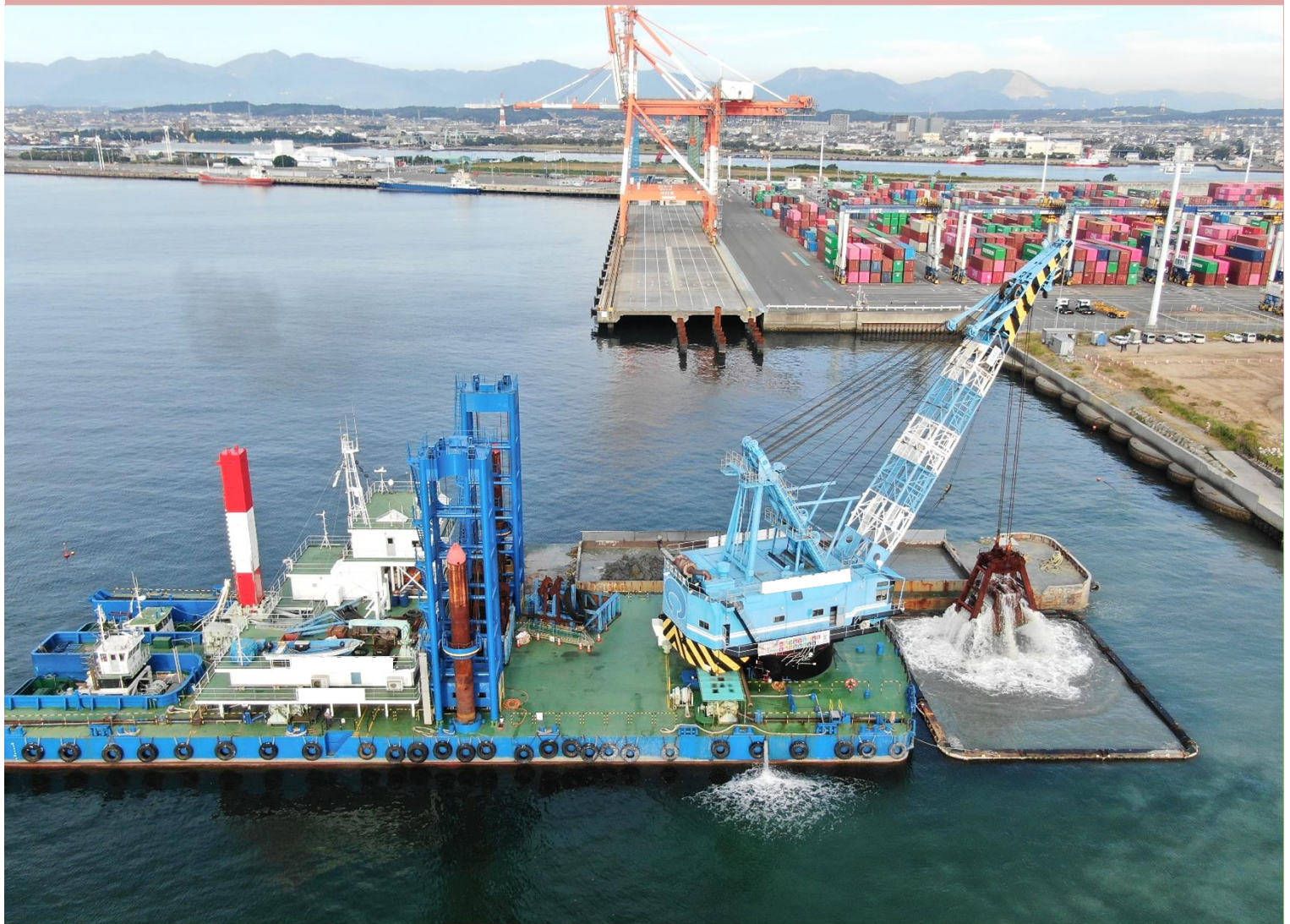
四日市港 床堀工事状況 (三重県) R5. 10月撮影
