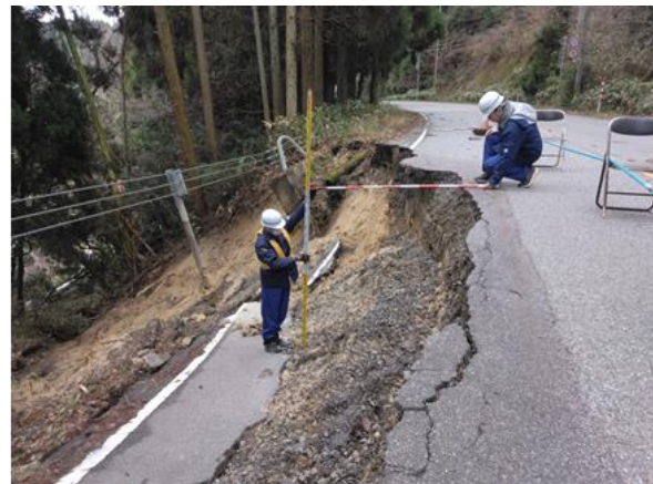
被災状況の調査
