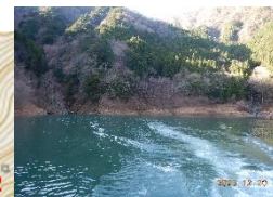
重代沢 (土砂・流木の流出状況を確認)
