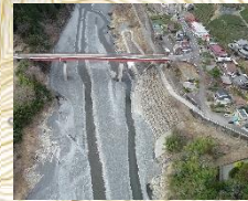
管理用通路(貯砂ダム坂路左岸) (道路等の異常を確認)
