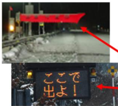
《エアースタイル遮断機・特設情報板稼働状況》 《エアースタイル遮断機・特設情報板の設置レイアウト》
