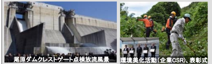
尾原ダムクレストゲート点検放流風景
