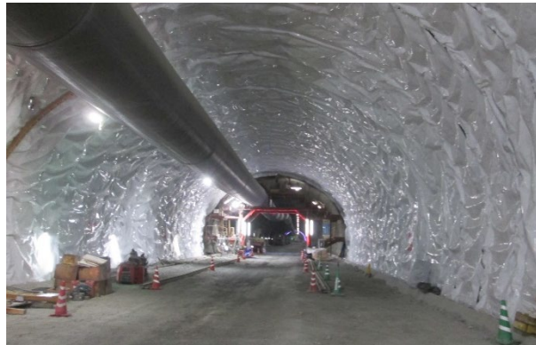
三遠南信自動車道 青崩峠道路 (長野県)
