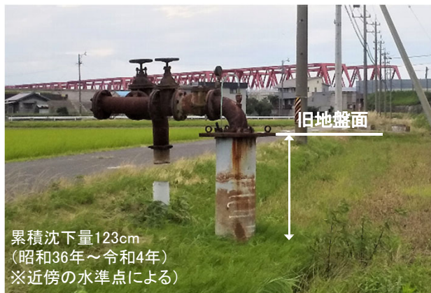
井戸の抜け上がり状況(三重県桑名郡木曾岬町) (令和3年6月撮影)
