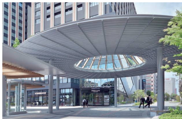
広場・歩行空間・各施設出入口が交差し広場の中心となる円形の大屋根下空間。長さ5.2mの扇形アルミキャストパネルを48枚連ねた。
