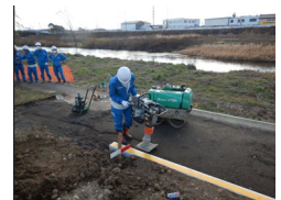
■路盤の締固め
