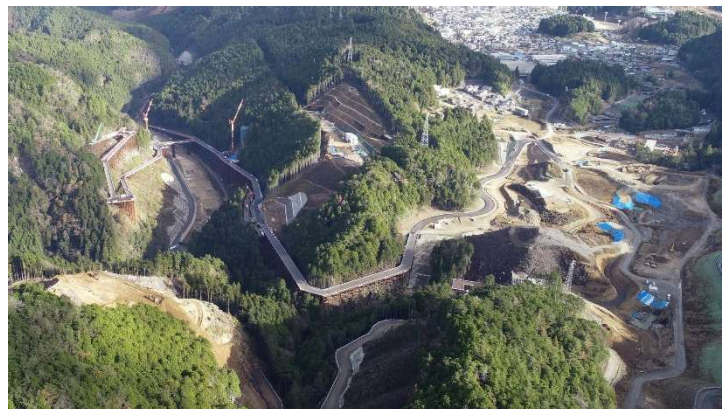
工事用道路(廃棄岩骨材運搬路等)
