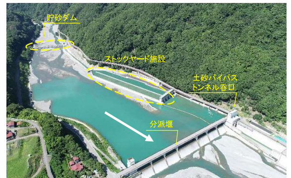
分派堰上流 貯水池堆砂対策施設
