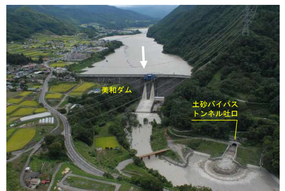
美和ダムと土砂バイパストンネル
