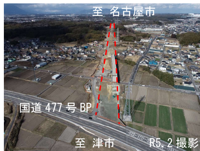
令和6年度開通に向け工事が進む 北勢バイパス 国道477号BP付近
