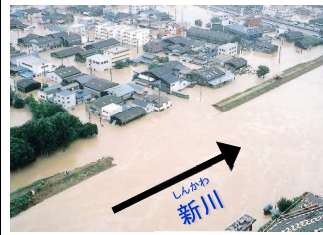
名古屋市区あし原町地先で新川堤防が決壊
