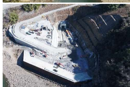
転流工吐口部施工状況
