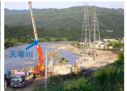
平成18年7月豪雨応急復旧状況
