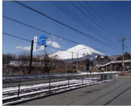
【整備事例】国道138号 須走電線共同溝
