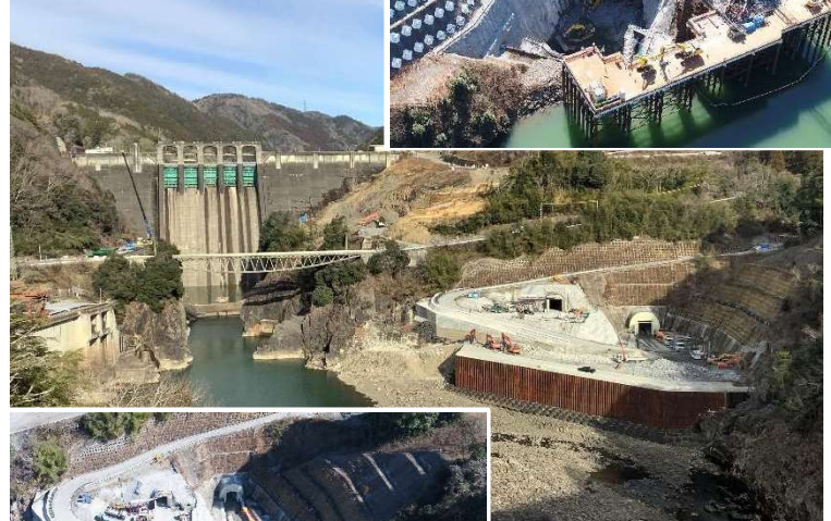
新丸山ダム本体付近施工状況
