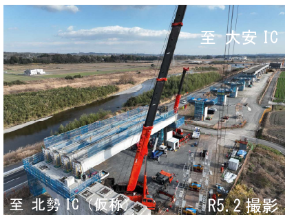
令和6年度開通に向け工事が進む 東海環状自動車道 北勢IC(仮称)～大安IC
