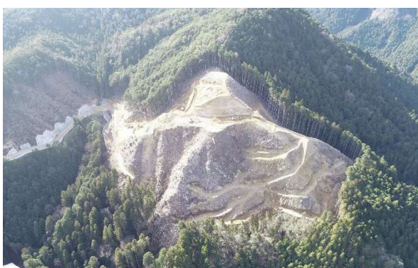
本体工事(基礎掘削)
