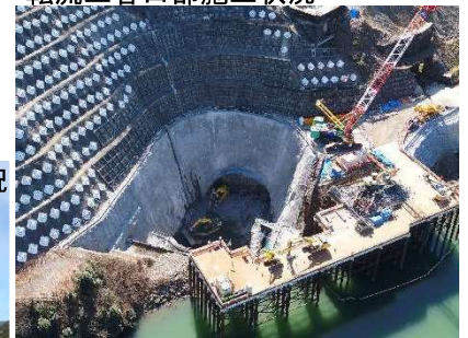
転流工呑口部施工状況
