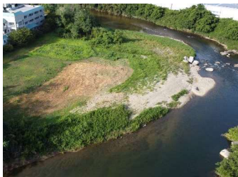
樹木等が繁茂し、水辺を安全に利用することが出来ない
