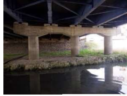
【対策事例】橋梁の耐震補強
