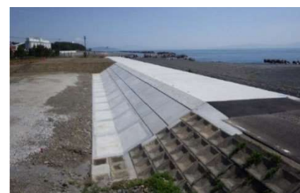
粘り強い構造の海岸堤防(焼津市)
