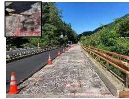
【対策事例】床版上面の断面補修
