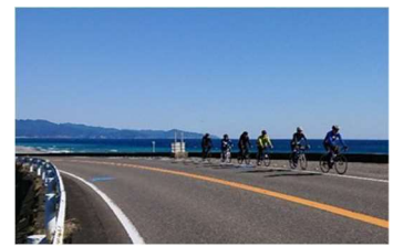
太平洋岸自転車道 国道42号(三重県御浜町)
