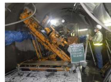
集水ボーリング工
