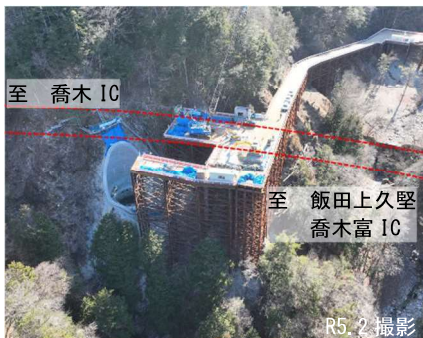
さんえんなんしん 三遠南信自動車道 いいだか 飯喬道路 喬木地区付近
