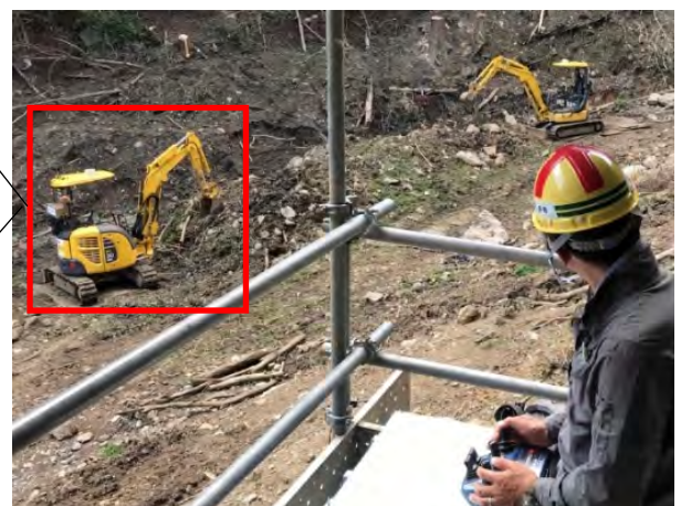
熱海市土砂災害での復旧作業状況
