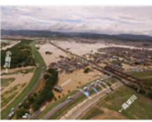
⑥ 小田川における浸水被害 (岡山県倉敷市)
