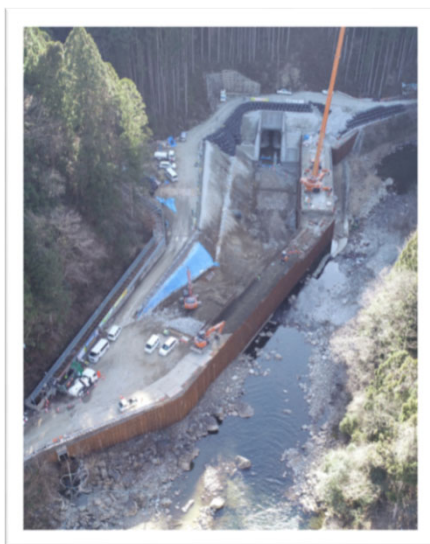
転流工呑口全景
