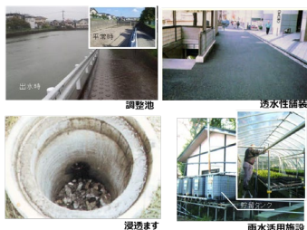
雨水貯留浸透施設の例
