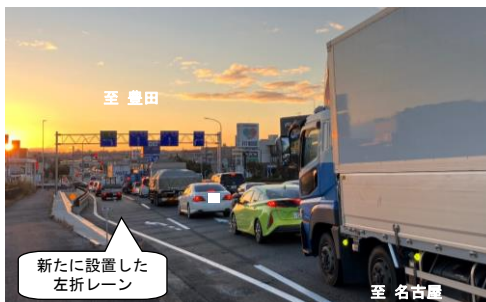
②西側流入部（国道153号）左折レーン新設
