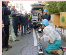
新技術の導入検討のための現場試行の調整
