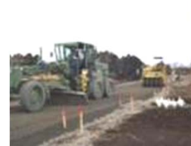
丁張りに合わせて施工
