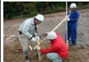
設計図に合わせて丁張り設置
