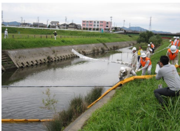
オイルフェンスの設置訓練
