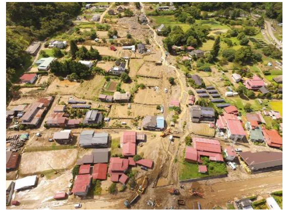
山地流域で発生した土砂の 下流河川における堆積と氾濫 (長野県茅野市)
