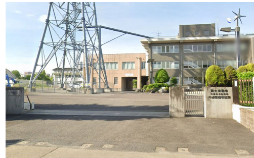
中部技術事務所 入口
