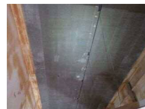
光ファイバースンサーによる 橋梁モニタリング
