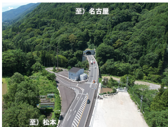
② 終点側坑口部 (R4.8撮影)
