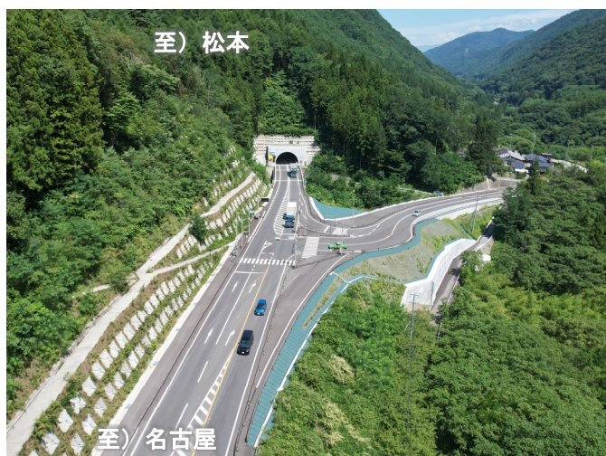
① 起点側坑口部 (R4.8撮影)
