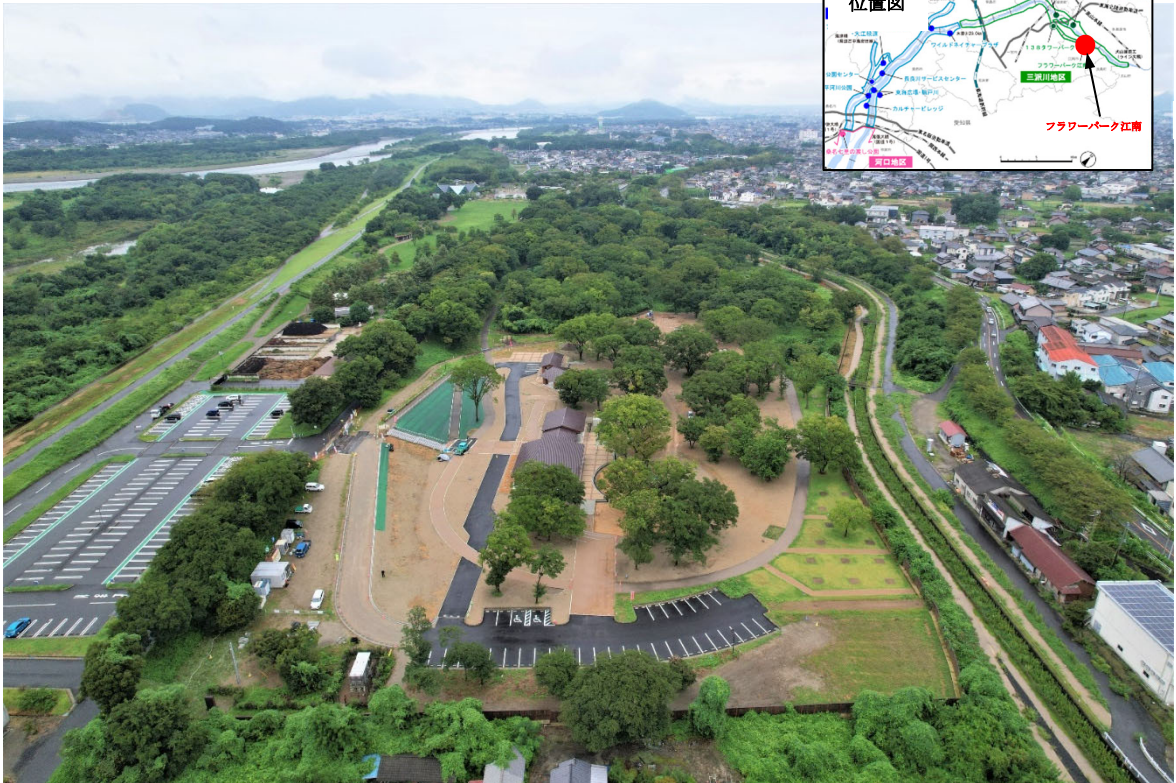
Ⅱ期地区(約 9.5ha)全景
