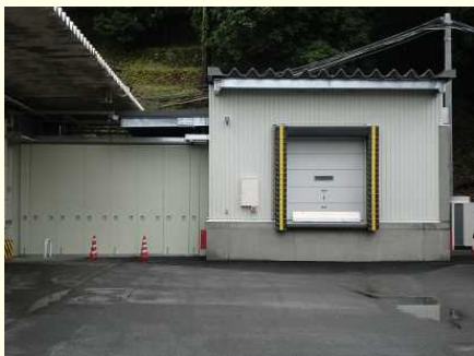
令和4年5月完成
