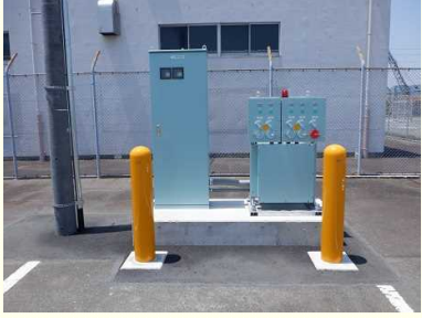
令和4年6月 完成
