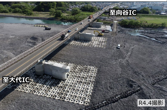
①新大井川橋において、橋梁上部工事を推進中
