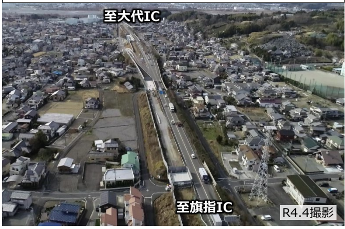
②向谷IC付近において橋梁上部工事を推進中
