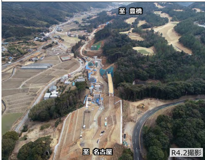
①金野地区において橋梁上下部工事を推進中
