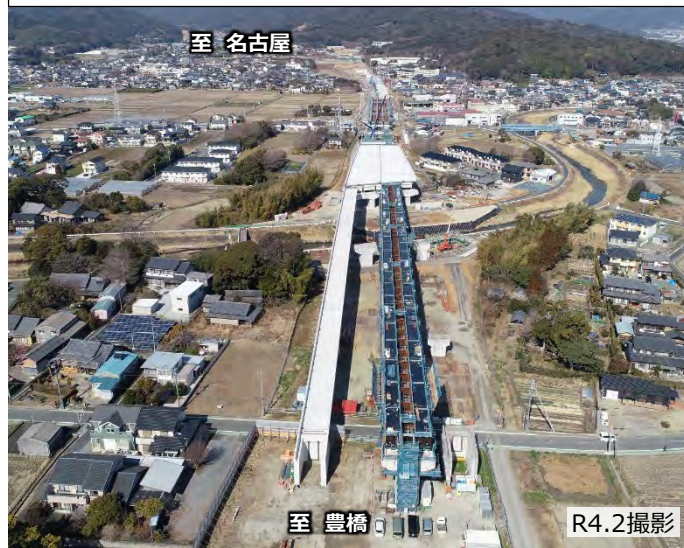
②為当地区において橋梁上部工事を推進中
