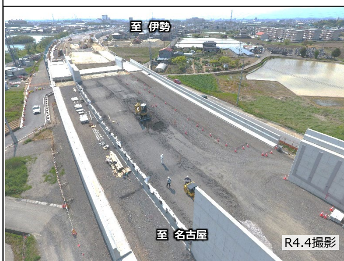
②玉垣地区において改良工事を推進中
