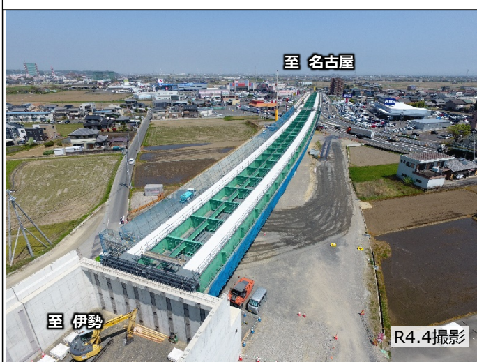
①北玉垣地区において橋梁上部工事を推進中
