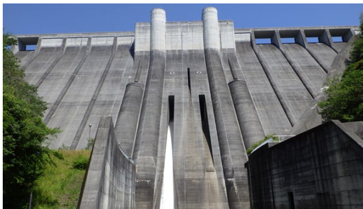
▲常用洪水吐からの放流（R1.5.10撮影）
