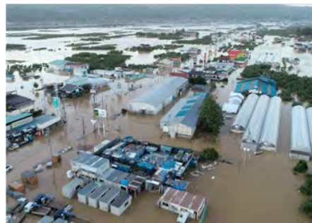
令和元年東日本 台風の被害 (長野県長野市)
