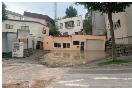
液状化被害の様子 （北海道胆振東部地震 札幌市清田区） （出典：内閣府「令和元年度 防災白書」）
