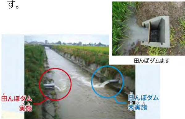
図 水田に雨水貯留機能を付与して治水対策への活用を図っている例
