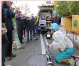
新技術導入の検討の現場試行の調整
