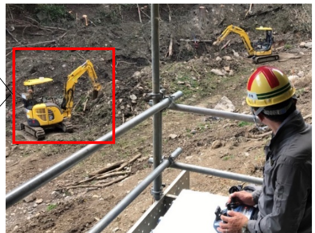
熱海市土砂災害での復旧作業状況
