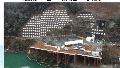
転流工呑口部施工状況
