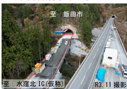
トンネル工事状況（静岡側） あおくずれとうげ 青崩峠道路
