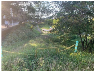
長良川左岸の現況
