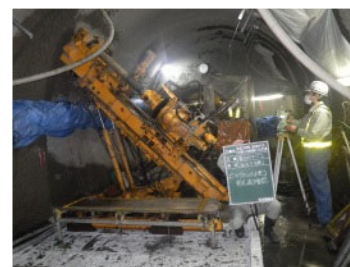
集水ボーリング工
