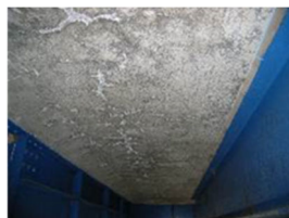
【対策事例】床版コンクリートひび割れ
