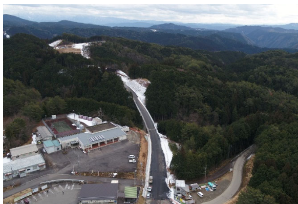
付替道路418号(潮見地区)
