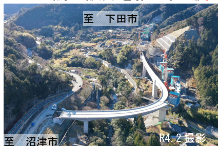
令和4年度一部開通に向け工事が進む かわづしもだ 河津下田道路（Ⅱ期） かわづ 河津IC（仮称）付近
