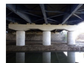
【対策事例】橋梁の耐震補強
