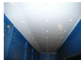
【対策事例】床版コンクリートひび割れ
