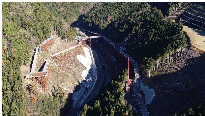
工事用道路(廃棄岩骨材運搬路等)
