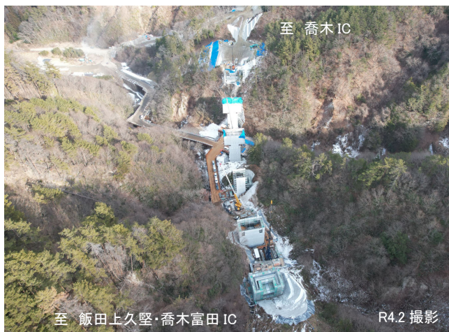
橋梁下部工の施工状況 いいだか 飯嵩道路
