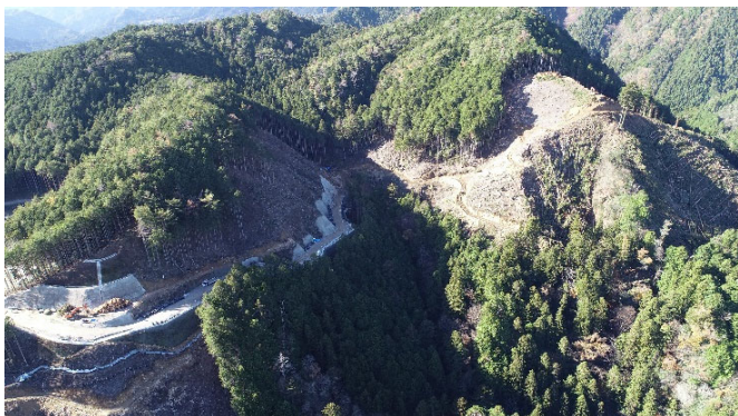
本体工事(基礎掘削)
