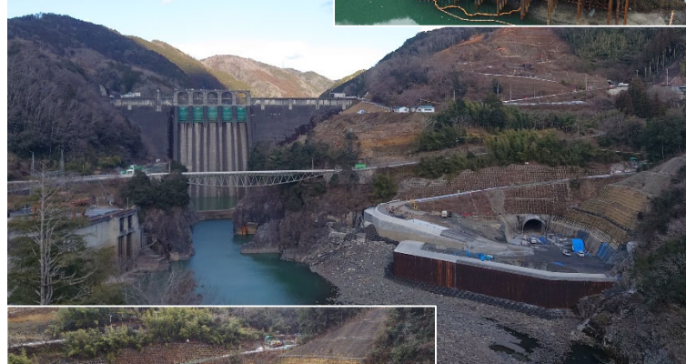
新丸山ダム本体付近施工状況
