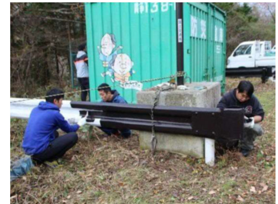
防護柵塗装(道路管理者と協同で実施)
