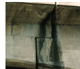
▲ゲルバー部の狭隘部
