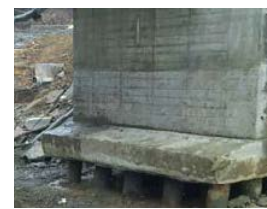
杭基礎の露出
