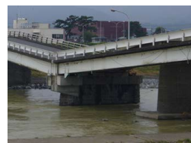
橋脚の沈下
