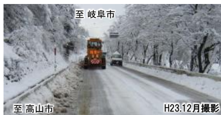
写真① 山間部の日陰部における路面凍結の発生状況
