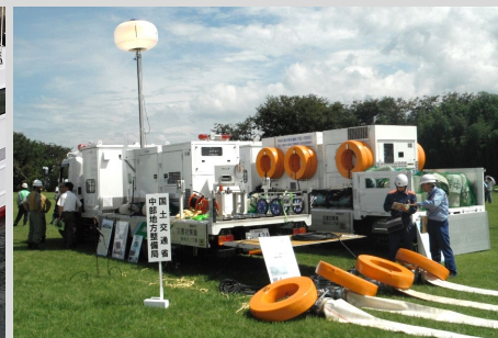
排水ポンプ車による排水作業
