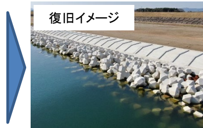
護岸工(コンクリート護岸+根固め工)を実施
