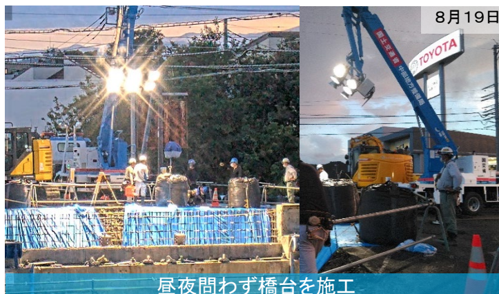
上空に高圧線・限られた施工ヤードに550tクレーン設置
