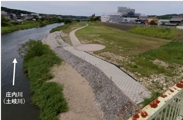
土岐津橋下流 (被災前)
