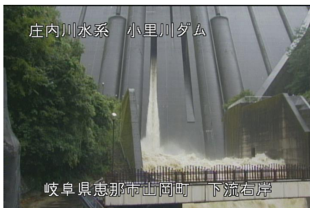
小里川ダムの放流状況（8月14日6時頃）
