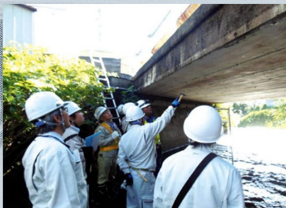
橋梁の現場実習
