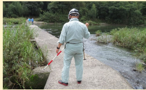
コンクリート橋（沈下橋）の現地調査
