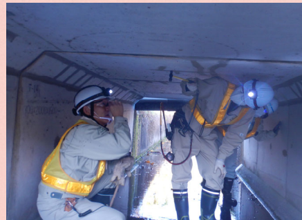
橋梁の点検に対する技術的助言
