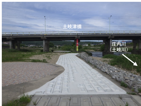
土岐津橋下流（被災前）
