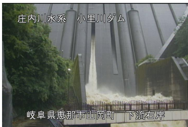
小里川ダムの放流状況（8月14日6時頃）
